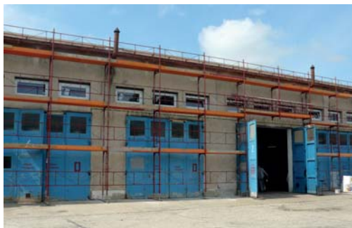
Az intézet garázsa felújítás közben (a Tököli Országos Büntetés-végrehajtási Intézet archívumából)
