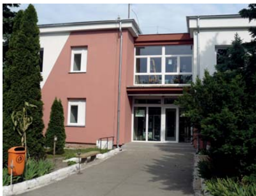
Parancsnoki épület felújítás után (a Tököli Országos Büntetés-végrehajtási Intézet archívumából)
